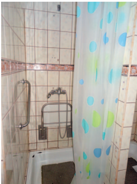
Wnętrze jednej z kabin prysznicowych dla skazanych (ZK Lubliniec)
