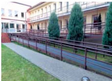
Pochylnie umożliwiające osobie z niepełnosprawnością wjazd wózkiem (DPS dla dzieci Ełk)
