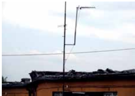
Zniszczenia pokrycia dachowego spowodowane pracą kopalni (ZK Jastrzębie Zdrój)
