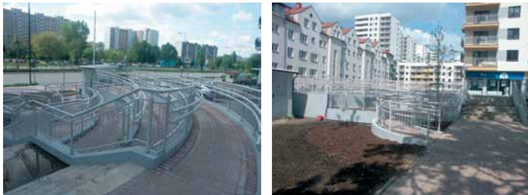
Ryc. 34 i 35. Zastosowanie pochylni przy dużych różnicach poziomów terenu nie zawsze jest rozwiązaniem estetycznym i w pełni funkcjonalnym. Warszawa-Jelonki (zdz. M. Wysocki).
