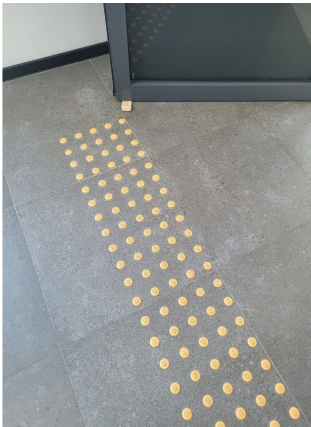
Zdjęcie 21. Kontrastujące z kolorem posadzki wypustki na podłodze przed drzwiami do lokalu wyborczego.
