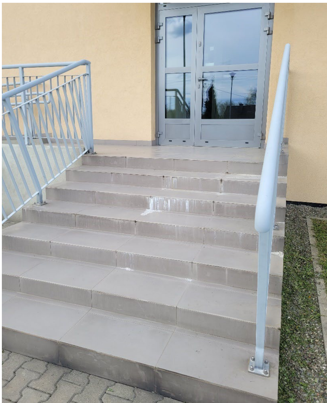
Zdjęcie 3. Schody prowadzące do lokalu w podobnym kolorze co chodnik przez lokalem i podłoga przy wejściu do lokalu..
