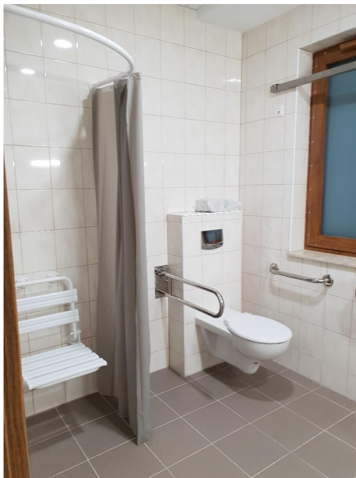
Zdjęcie 7. Łazienka dostosowana do potrzeb osób z niepełnosprawnościami w SOC w Kętrzynie
